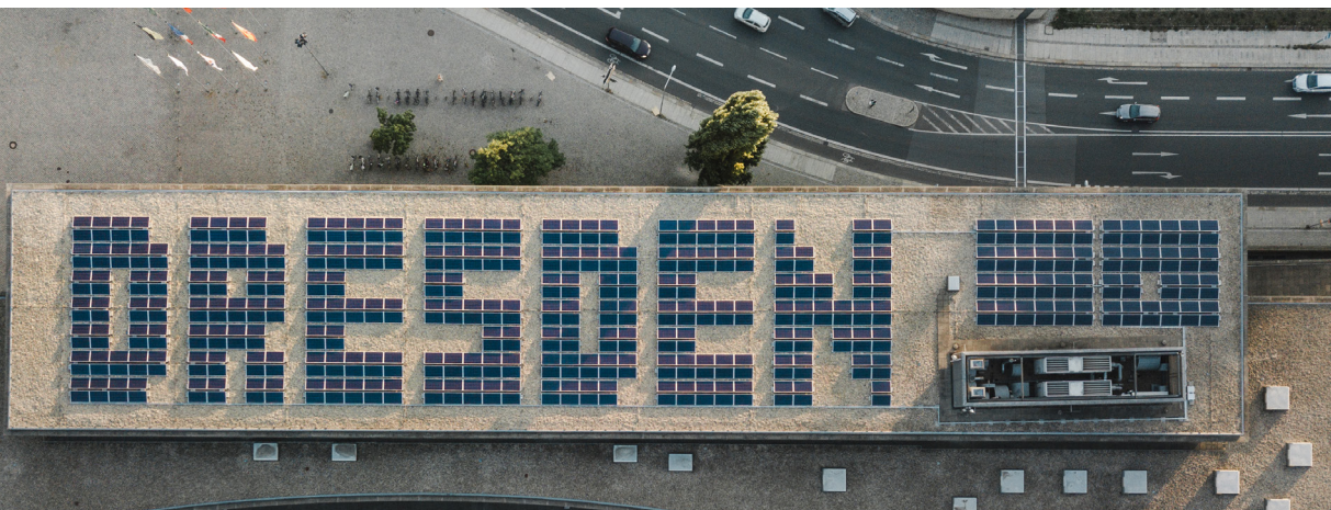
Photovoltaikanlage als Schriftzug „DRESDEN“, Foto: Sebastian Weingart
