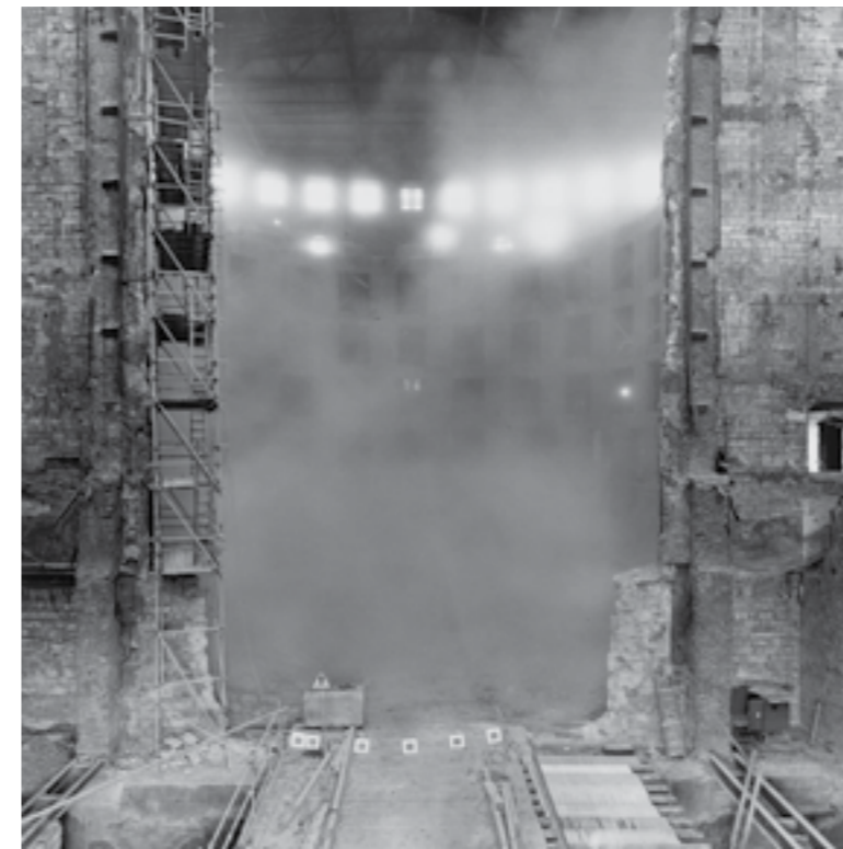
Christian Borchert, Baustelle Semperoper (Blick durchs Bühnenportal in den Zuschauerraum), 1977
